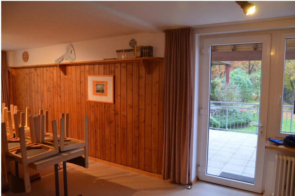
Ansicht 3: Terrassentür und „West“-Wand mit senkrechter Anordnung der Holzpaneele
